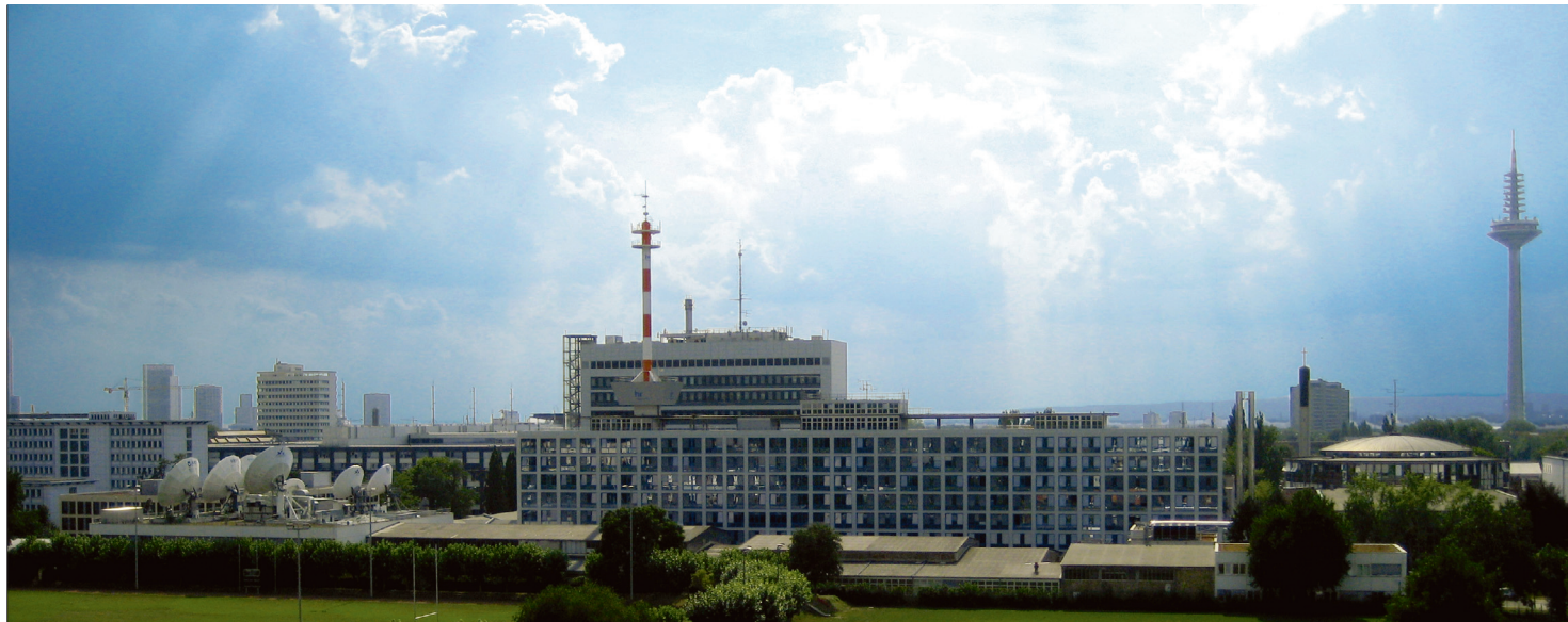
Die perfekte Welle sucht hr3 und verzichtet dabei auf die alten Radiohaudegen
